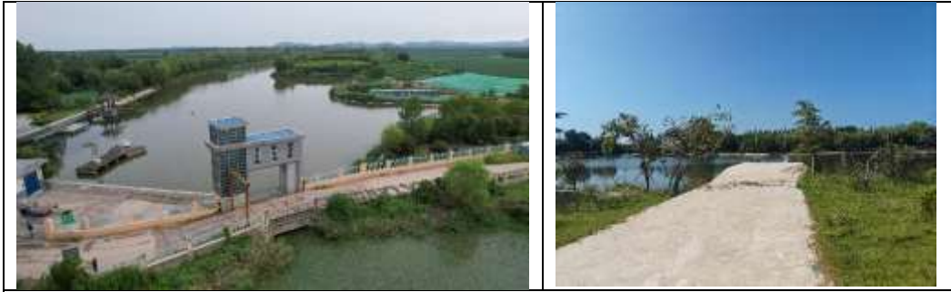
取水口恢复情况
