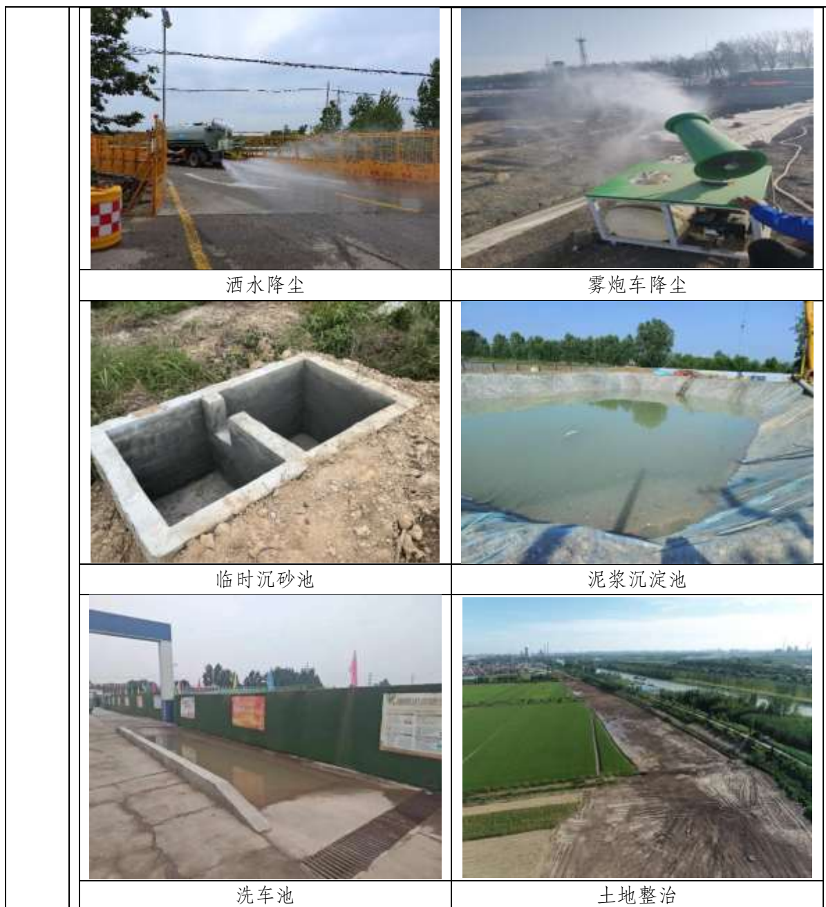
图 7-1 项目施工现场照片
